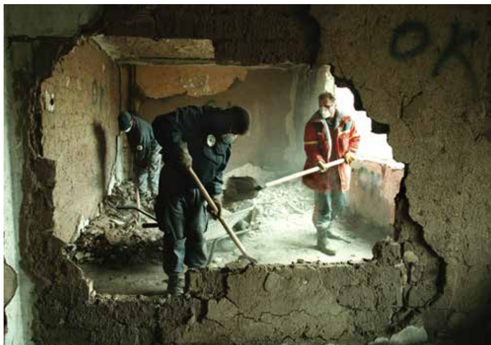
SARAJEVO: Krevende arbeidsforhold for mineryddere fra Norsk Folkehjelp som rydder en utbombet bygning i Grbavica, en forstad til Sarajevo i 1997. FOTO: ANJA NIEDRINGHAUS/EPA/NTB/
