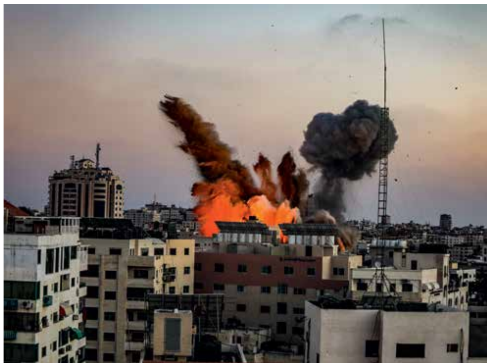
ØDELAGT: 1128 bygninger ble ødelagt og 15129 bygninger ble delvis ødelagt i løpet av 11 dagers bombing på Gazastripen.
