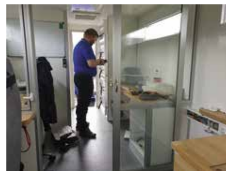
HÅ: Cato Grytten driver med innredning klargjøring av KO-vagn. Han tester og merker nettskabeler
